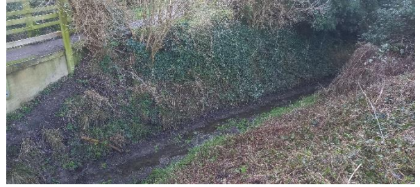
Figure TR5.1.A-10 – Confluence ditch
